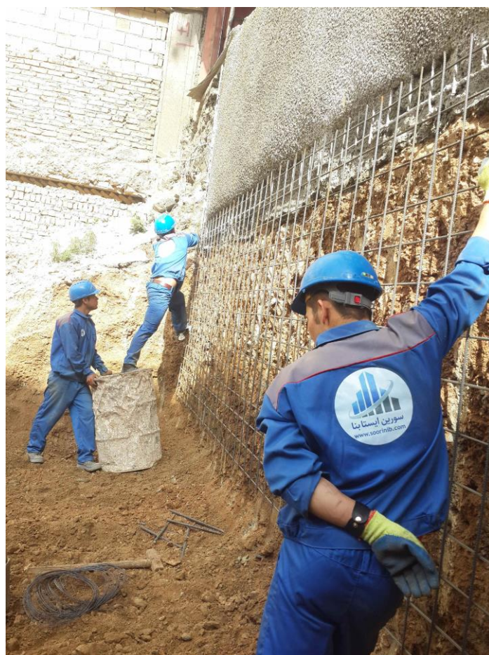
شکل 1-4 مرحله چهارم اجرای دیوار میخکوبی شده (ساخت رویه موقت شاتکریت)
