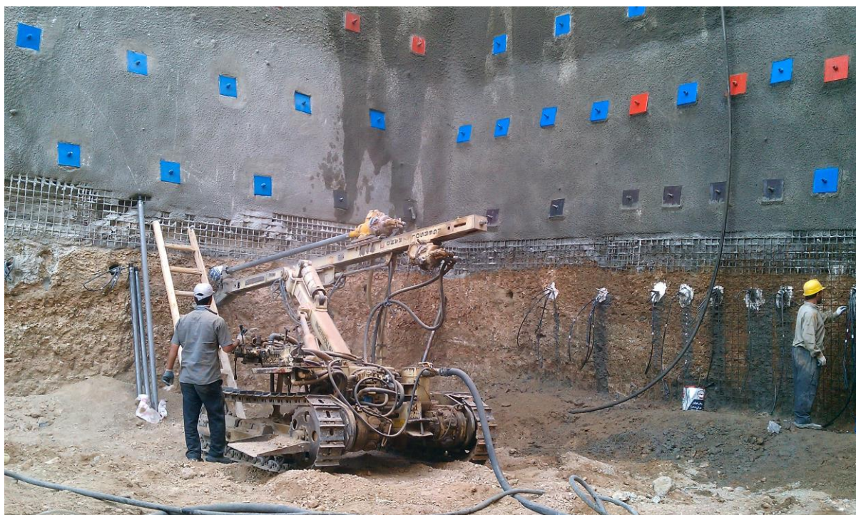
شکل 1-2 مرحله دوم اجرای دیوار میخکوبی شده (حفر گمانه‌ها)
