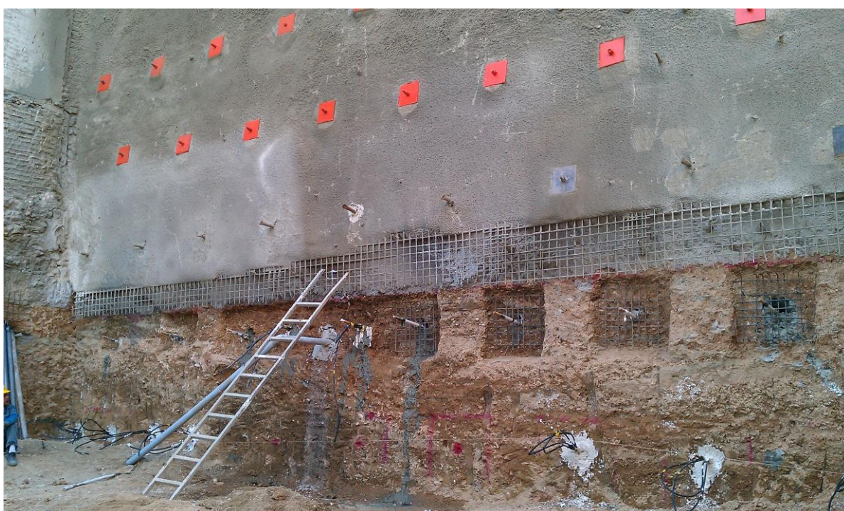
شکل 1-3 مرحله سوم اجرای دیوار میخکوبی شده (نصب میلگردها و تزریق دوغاب)
